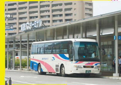
Terminal bus cepat di Stasiun Takamatsu
